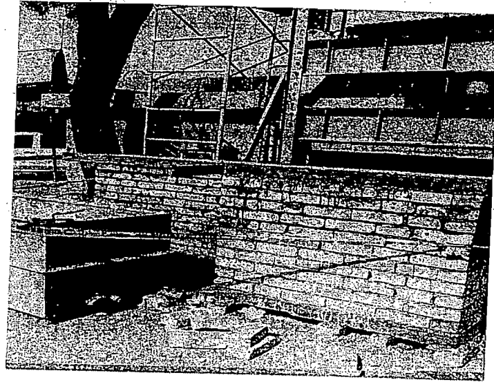
ج- نماذج الجدران المجوفة بعد إكمال التشييد
